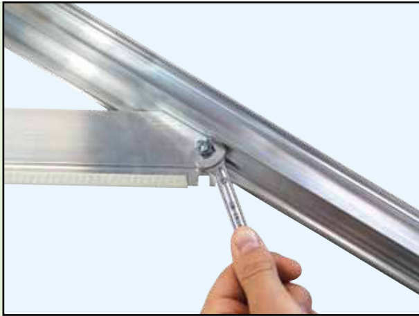
7. Dveřní závěs Door hinge strut
